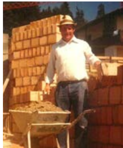
In jungen Jahren: Meinrad Vent auf der Baustelle am Loambichlweg (im Jahr 1981)
