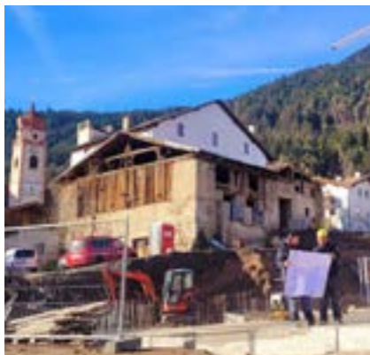
Lukas und Markus Vent auf der Baustelle in Tisens
